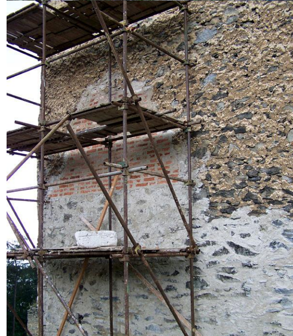
Rekonstrukce niky východní části zdiva jádra, srpen 2011. Převzato z: Oficiální fotogalerie Občanského sdružení pro záchranu hradu Kostomlaty na volny.cz
