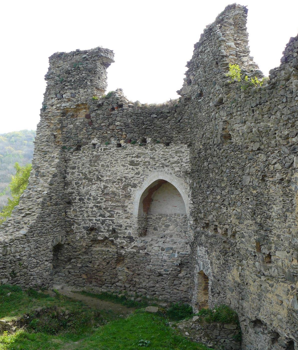
Rekonstrukce niky východní části zdiva jádra, srpen 2011. Převzato z: Oficiální fotogalerie Občanského sdružení pro záchranu hradu Kostomlaty na volny.cz
