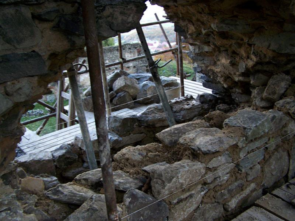
Zazdívání kaverny západní stěny jádra, září až říjen 2010. Převzato z: Oficiální fotogalerie Občanského sdružení pro záchranu hradu Kostomlaty na volny.cz
